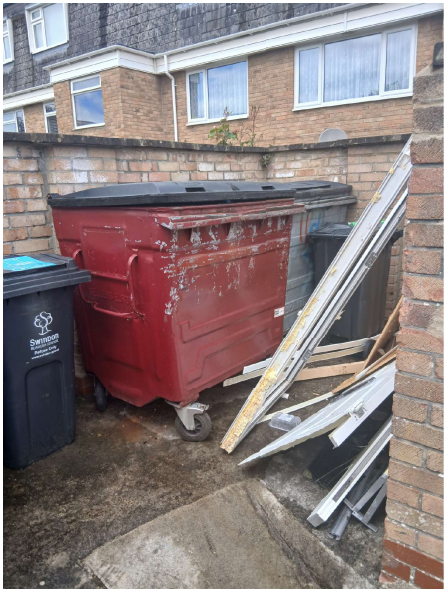
Bin Store (Waste Disposal Area)
